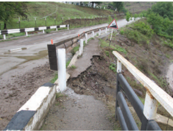
地滑りに耐え切れず崩壊した道路。 © UNDP Tatevik Ghazaryan
