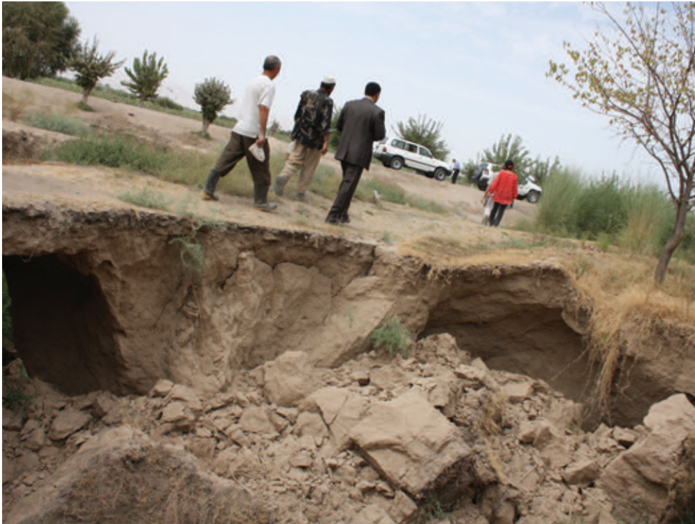
土地の劣化が原因で崩壊した道路。
