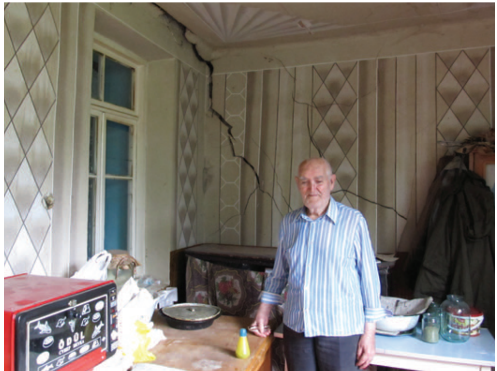
地震の衝撃でひび割れた壁。災害が人間開発に及ぼす影響の大きさを示しています。
